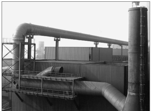
Kompensatoren am Anfang einer Wärmerückführung einer Sinteranlage
